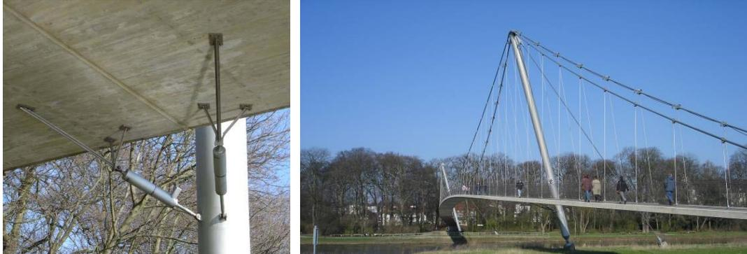
Figure 6-1 : Amortisseurs visqueux installés sur la Passerelle Minden (Allemagne)
