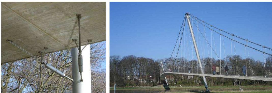
**Figura 6-1: Amortecedores viscosos instalados na ponte pedonal de Minden (Alemanha)**
