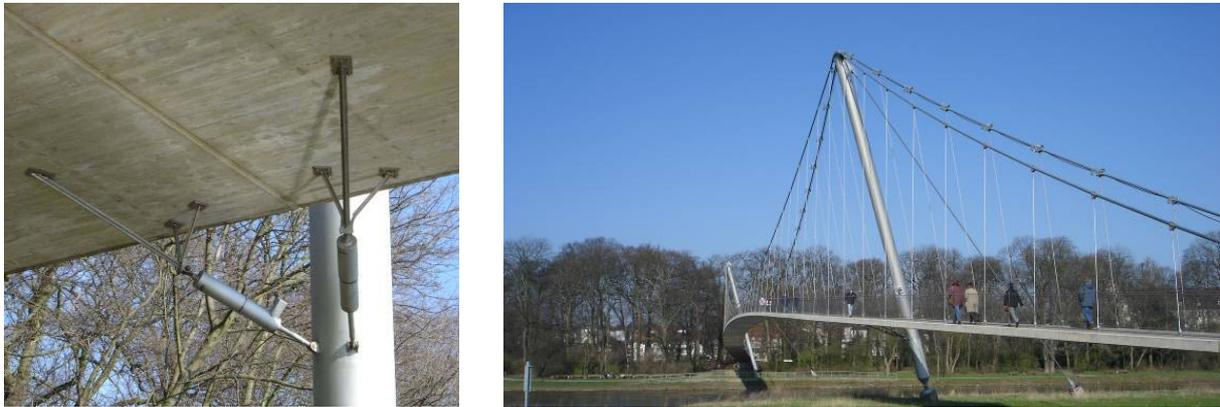
**Bild 6-1: Beispiel für einen installierten viskosen Dämpfer**
