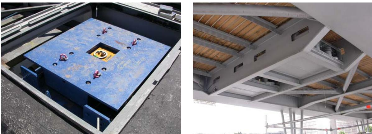
**Bild 6-2: Beispiele für eingebaute Massedämpfer (TMDs)**
