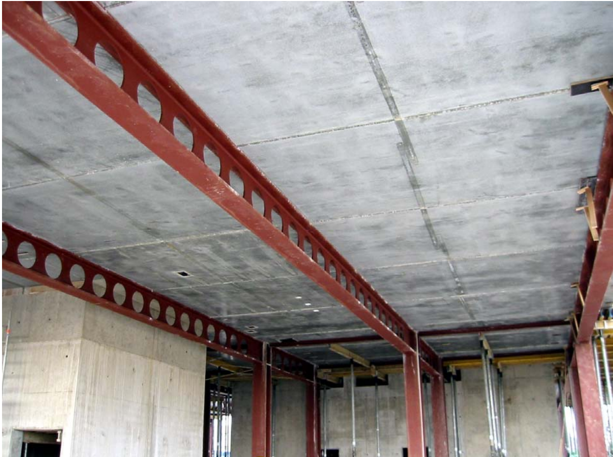
Bild 14: Tragwerk des Gebäudes
