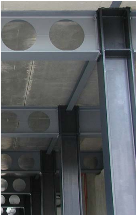
Bild 16: Träger-Stützen Verbindung
