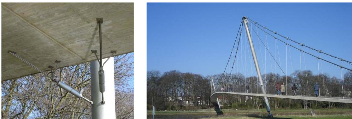
Figure 6-1 : Exemple d'amortisseurs visqueux installés
