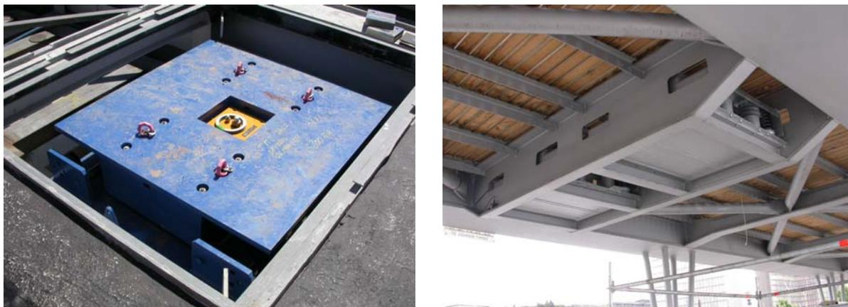
Figure 6-2 : Exemples de TMD installés
