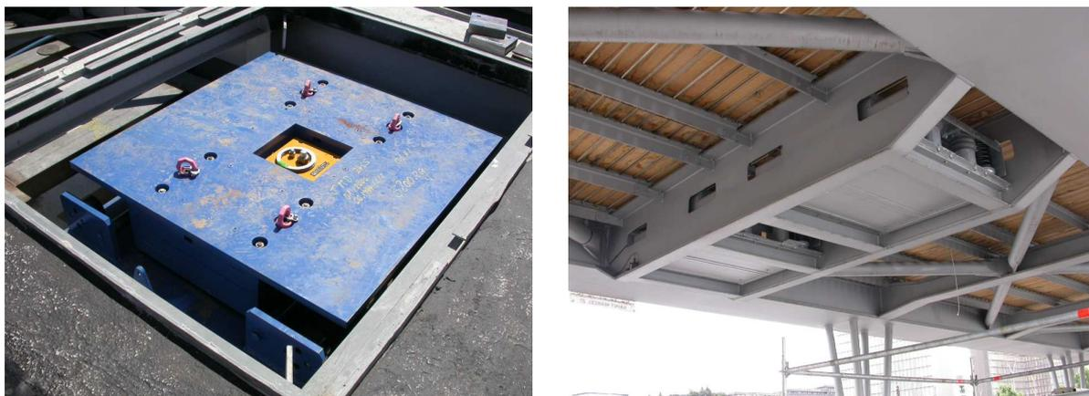
**Figura 6-2: Exemplos de TMDs instalados**
