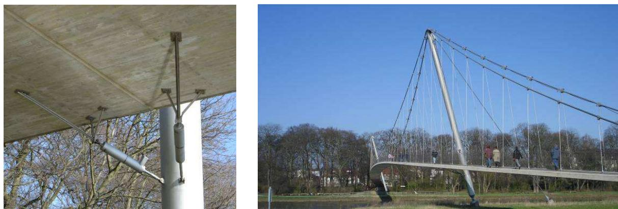
**Figura 6-1: Um exemplo de amortecedores viscosos instalados**
